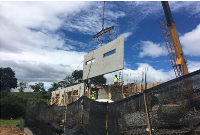
MONTAJE DE PAREDES CON TEXTURA
