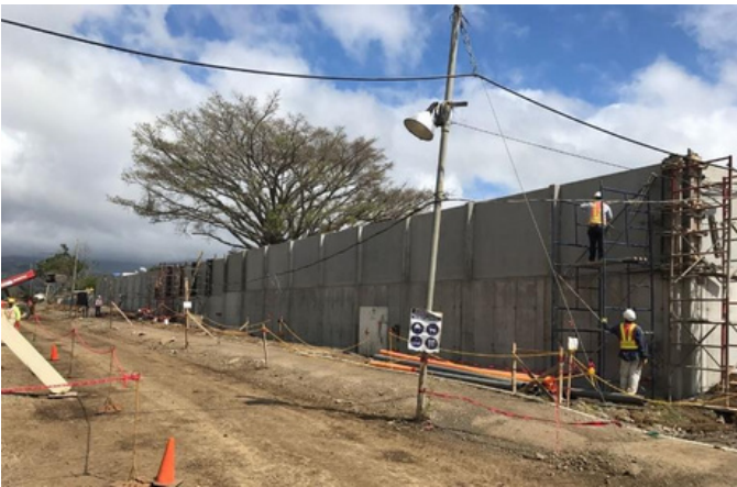
MURO COLINDANCIA PROYECTO CENCE/ SAN MIGUEL DE SAN ISIDRO DE HEREDIA
